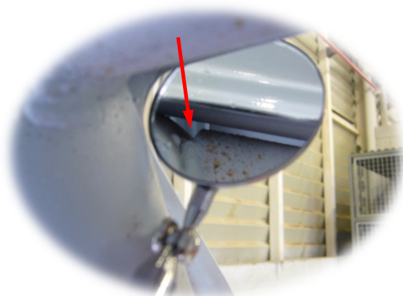
Tubo sin soldar en la unión
